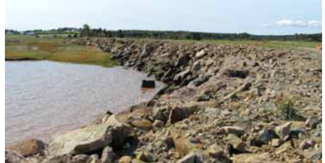
Section de digue dans la région de Tantramar
