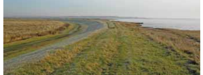
Tronçon de digue le long de la baie de Fundy.
